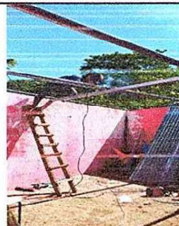
Foto 2: DESARMANDO DE ESTRUCTURAS DE LA DIRECCIÓN.
