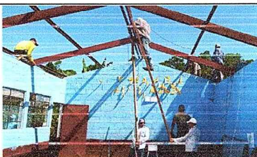
Foto 4: INSTALACIÓN DE COSTANERAS PARA AULA 2.
